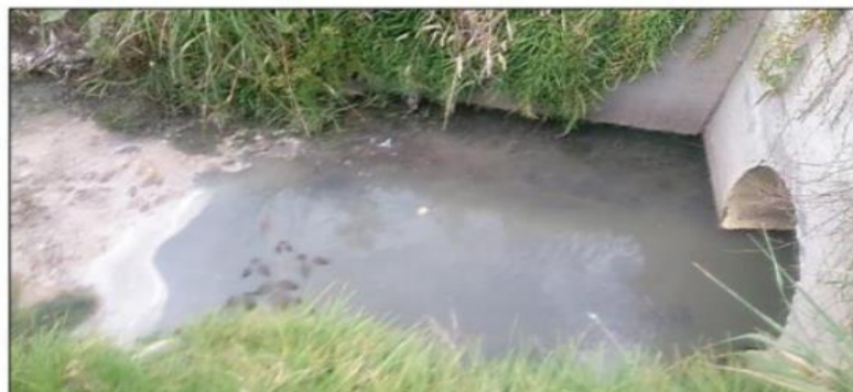
foto 1 Vertimiento Sistema de Alcantarillado Municipio de Aldana
