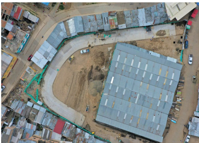
El mejoramiento de las vías internas de la plaza de mercado El Potrerillo permite que los comerciantes y usuarios tengan una mejor movilidad.
