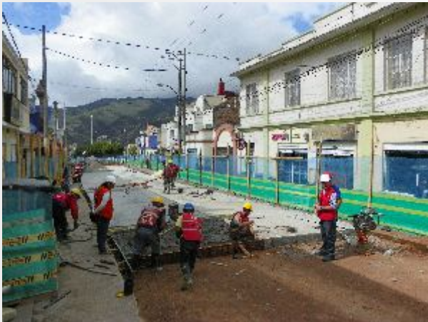
Pavimentación Calle 20 desde la Carrera 30 hasta la Carrera 32 3
