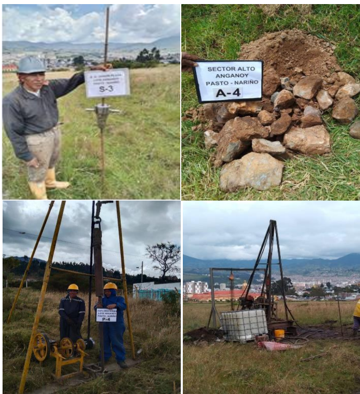
Figura 55 Ejecución de sondeos, apiques y perforaciones. Fuente: Este estudio.
