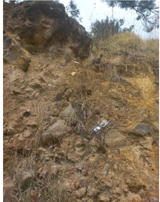
Figura 29. contacto entre Stfe y Rdfl.
