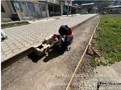
ENSAYOS DE DESNDIDADES A SUB BASE GRANULAR
