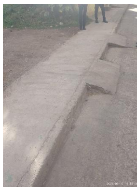
RAMPAS DE ACCESO VEHICULAR POR PARTE DE LA COMUNIDAD
