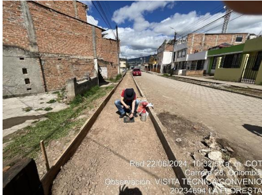
ENSAYOS DE DESNDIDADES A SUB BASE GRANULAR
