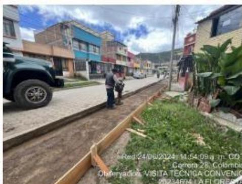
RELLENO Y COMPACTACION SUB BASE GRANULAR
