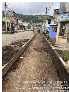
COMPACTACION SUB BASE GRANULAR
