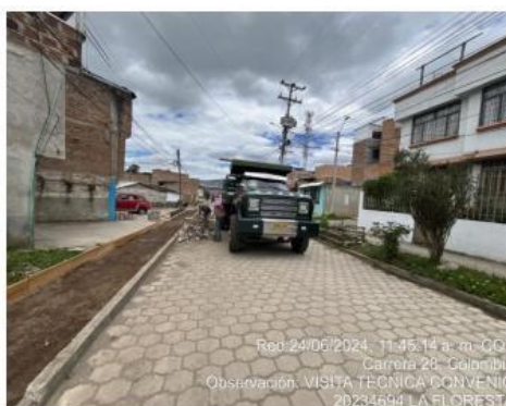
DESALOJO DE MATERIAL PROVENIENTE DE EXCAVACION
