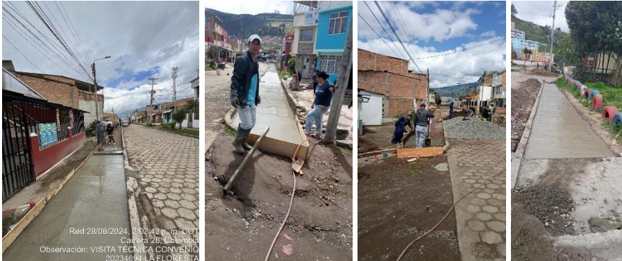
ALINEACION FORMALETA, VIBRADO DE CONCRETO, FUNDICION EN SITIO
